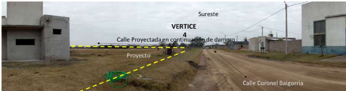
Foto N°2: Vista hacia el vértice 4. Se observa la casa que se encuentra en construcción.
